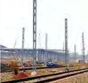
Tata Steel Plant – Kalinganagar (Odisha)
